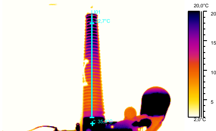
Рисунок 4.2 – Термография на локальные перегревы дефектных участков
